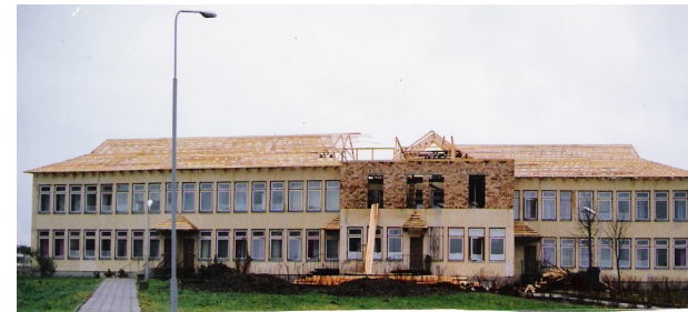
Pastato I korpuso rekonstrukcija
