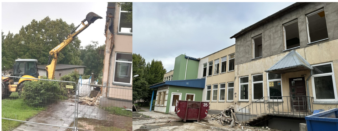
Pastato rekonstrukcijos darbai įsibėgėja
